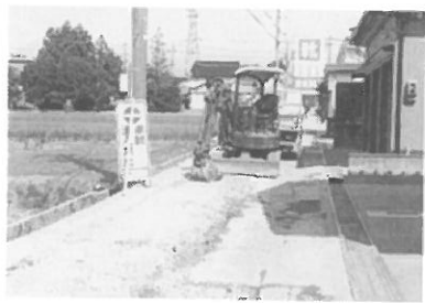
下水管の敷設工事
