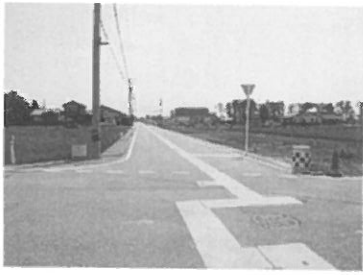
道路拡幅場所
