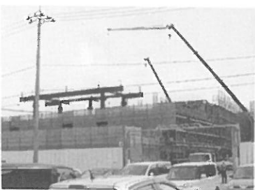
建設中の カリエール
