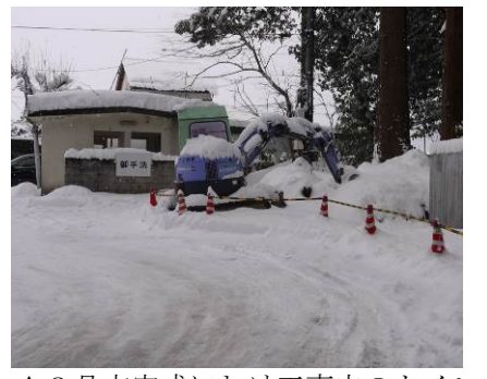
▲3月末完成にむけ工事中のトイレ
